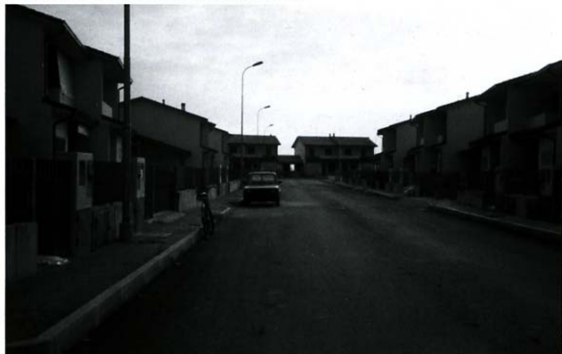
Alloggi "La Famiglia" in fase di ultimazione ad Olmeneta (Cremona).
