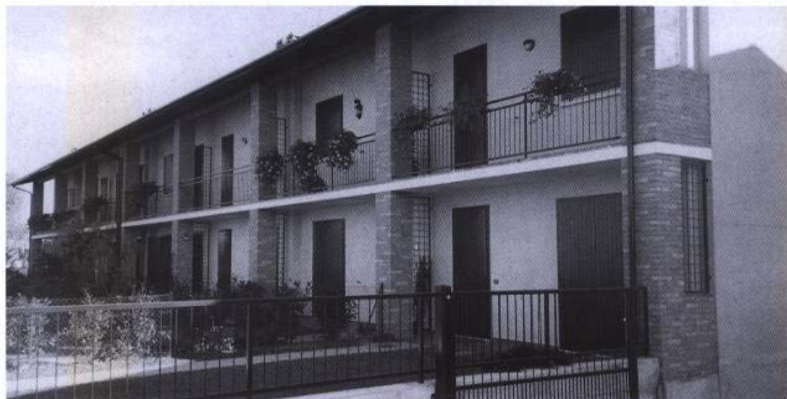
Una delle nuove tipologie di costruzione a schiera.
