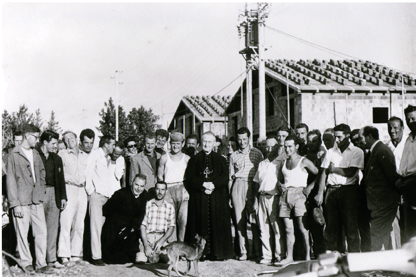
Padre Marcolini con gli operai del cantiere Villaggio Sereno insieme a mons. Giacinto Tredici Vescovo di Brescia
